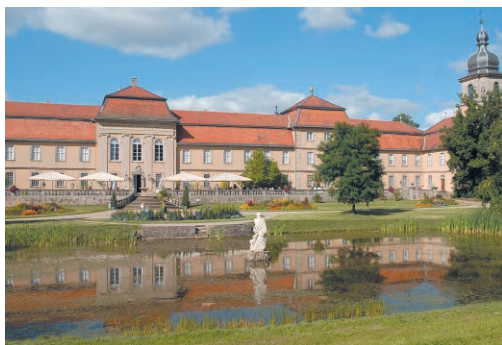
Blick auf die südliche Schlossfassade
